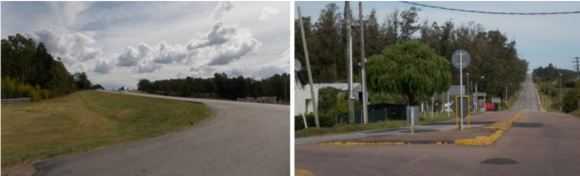
Fig.18: Vías de tránsito. Izq.: Ruta 9; Der.: Ruta 71
