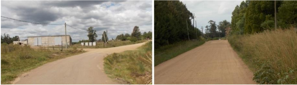
Fig.16: Vías de tránsito. Izq.: Ruta 73; Der.: Ruta 72
