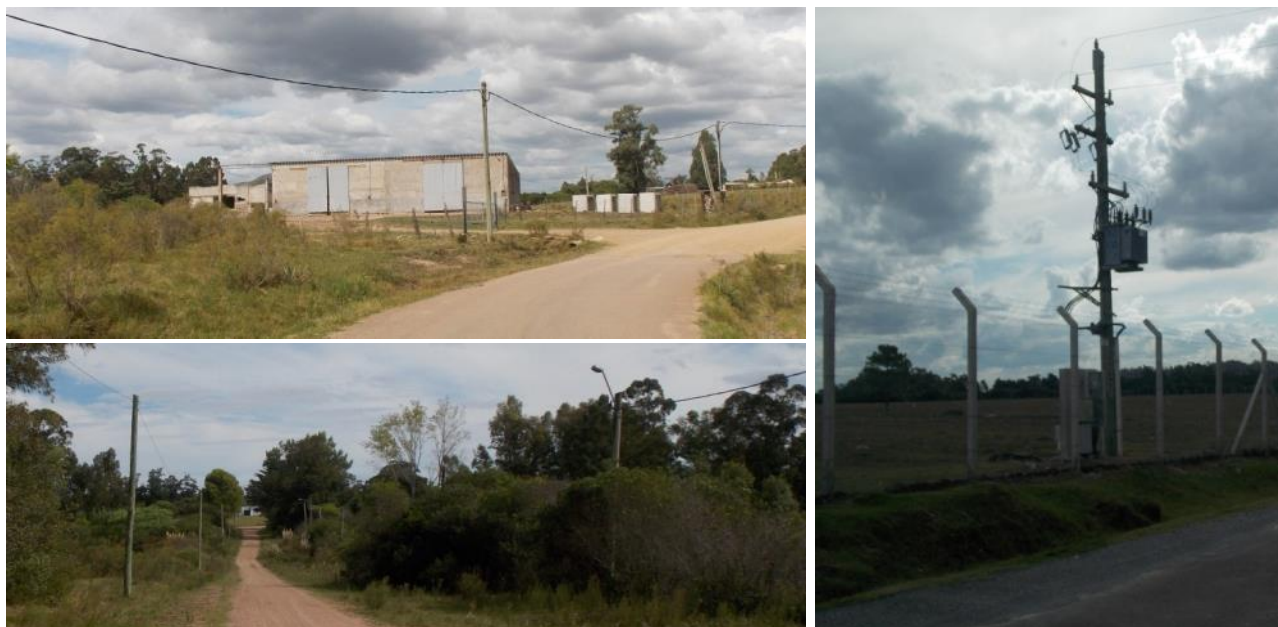
Fig. 20: Tendido eléctrico dentro del ámbito de actuación.
